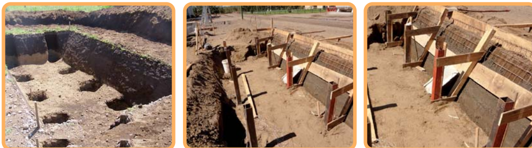
Figura 3.6. Instalación de pilares de fundación y malla metálica
