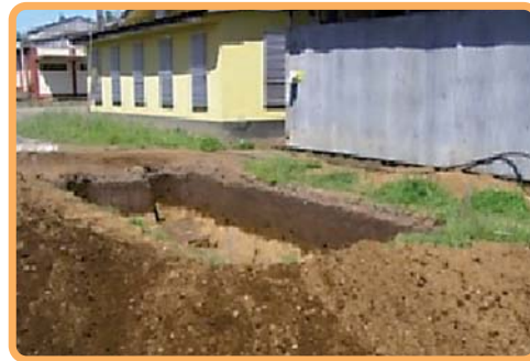
Figura 3.5. Trazado y excavación para la construcción del lecho
