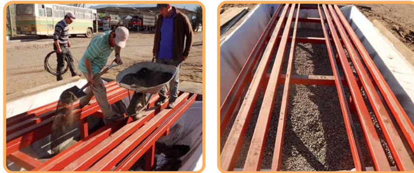
Figura 3.13. Incorporación de arena y gravilla
