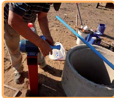
Figura 3.11. Instalación de sistema de recirculación
