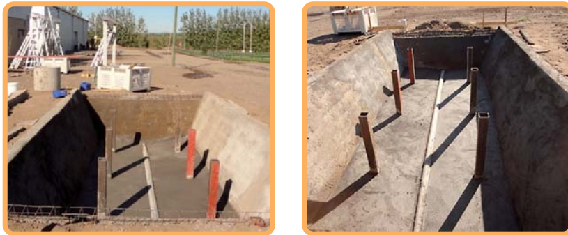
Figura 3.8. Excavación impermeabilizada
