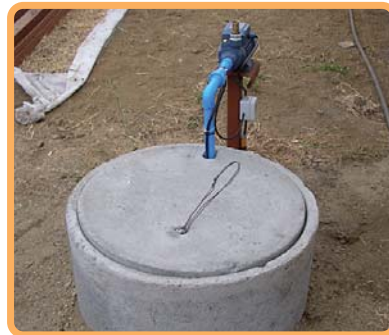
Figura 3.11. Instalación de sistema de recirculación
