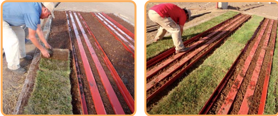
Figura 3.15. Instalación de pastelones de césped sobre superficie de lecho biológico
