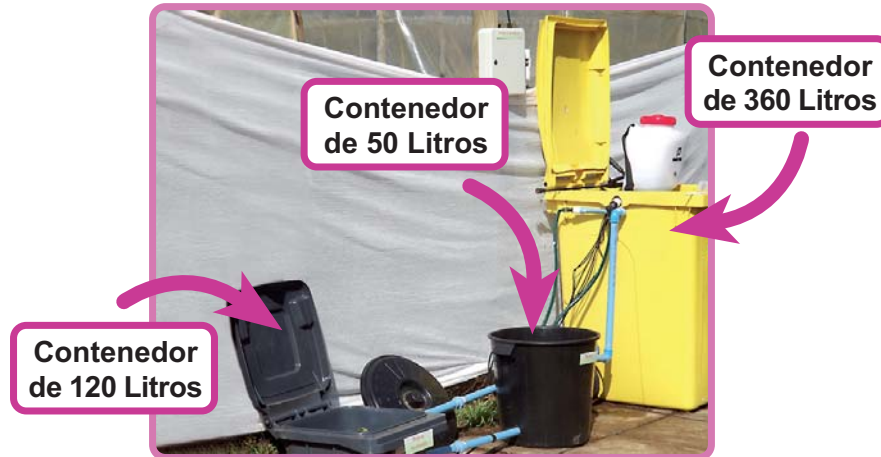
Figura 4.3. Disposición de los tres contenedores que forma parte del lecho biológico
