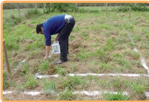
Figura 3.5. Trazado y excavación para la construcción del lecho
