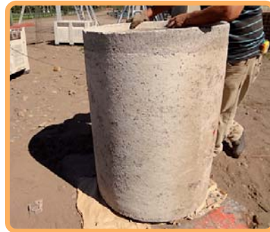
Figura 3.10. Excavación, 4 tubos de hormigón utilizados para la construcción del pozo de recolección
