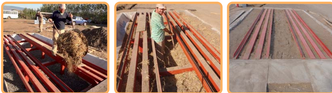
Figura 3.14. Secuencia del proceso de llenado del lecho biológico
