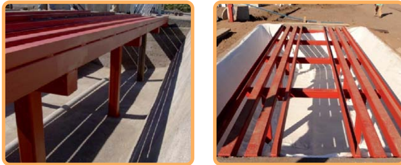
Figura 3.9. Instalación de la rampa metálica
