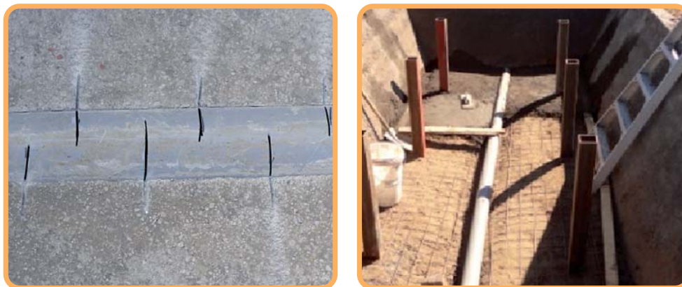
Figura 3.7. Instalación de tubo perforado para drenaje
